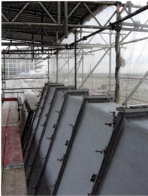
**Bild 4.** Die abgedichteten Fassadenflächen vor der Montage der Fassadenplatten
