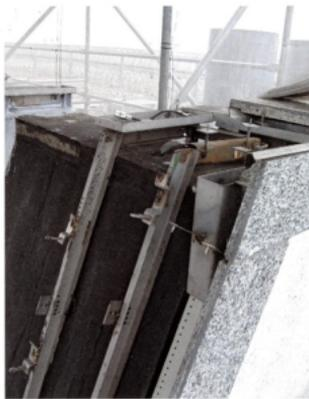
**Bild 2.** Die Unterkonstruktion nach dem Entfernen der Fassadenelemente
