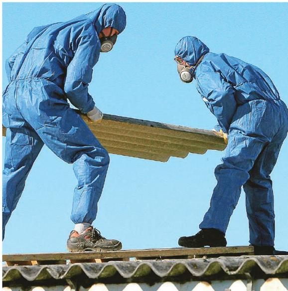
Bei der Sanierung einer Immobilie mit Asbest sollten die Profis ran. Zum Schutz ihrer Gesundheit entfernen sie in Schutzanzügen und mit Luftfiltern über Mund und Nase die mit Asbest belasteten Teile.
