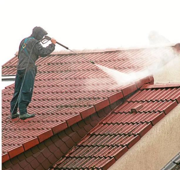
Laien sollten dem Dach lieber nicht mit dem Hochdruckreiniger zu Leibe rücken, da der starke Wasserstrahl die Dachhaut und damit auch die Wärmedämmung gefährden kann. Besonders wichtig ist die Reinigung der Regenrinne, in der sich häufig Sand, Laub und Nadeln sammeln, damit sich das Wasser nicht sammelt, sondern ungehindert abfließen kann.
